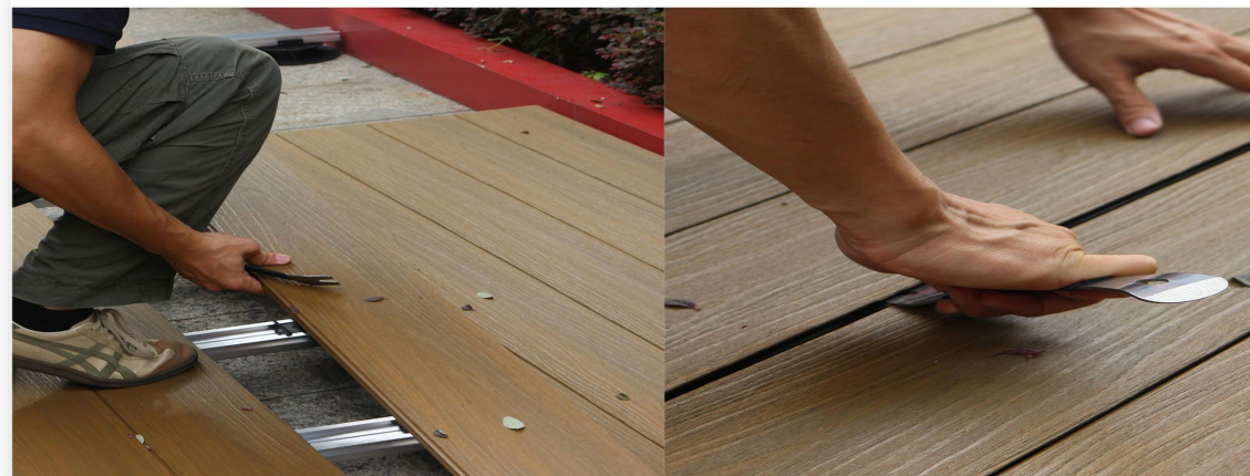
ร่องชนิดสนิท แต่น้ำยังไหลผ่านลงรางระบายใต้แผ่นได้ดี
